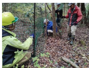
既存の植生保護柵は、下部がシカやイノシシにより穴を開けられてしまうため、金属ネットを追加で設置して補修しました
