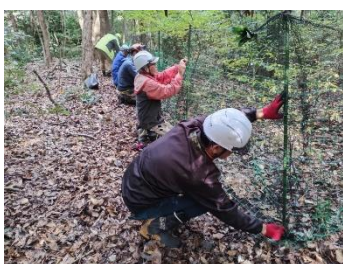
既存の植生保護柵は、下部がシカやイノシシにより穴を開けられてしまうため、金属ネットを追加で設置して補修しました
