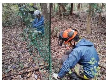
既存の植生保護柵は、下部がシカやイノシシにより穴を開けられてしまうため、金属ネットを追加で設置して補修しました
