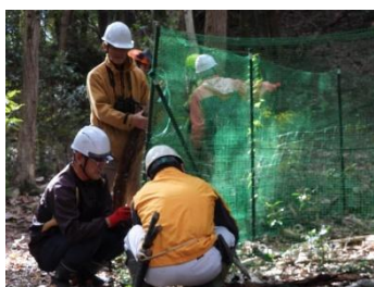
既存の植生保護柵は、下部がシカやイノシシにより穴を開けられてしまうため、金属ネットを追加で設置して補修しました
